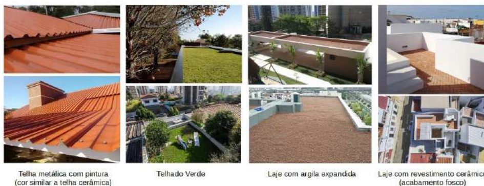
Figura 04: Ilustrações acabamentos cobertura. Fonte: Parecer Técnico nº 90/2024. 04 de dezembro/2024.
